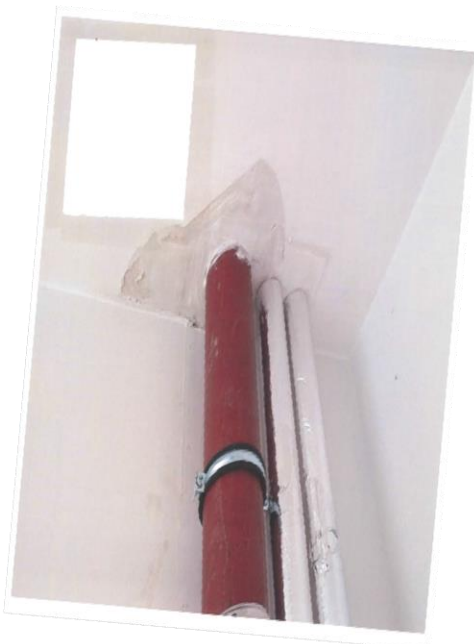
Fotografi af en tilstøbning som er klar til malerens spartling og slutbehandling.
