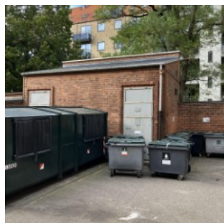
Containere placeret mindre end 5 meter fra bygning
