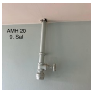
Stigerør på 9. sal i opgange
