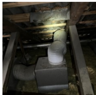
Aksels Møllers Have 6 - Ventilations hætte faldet ned
