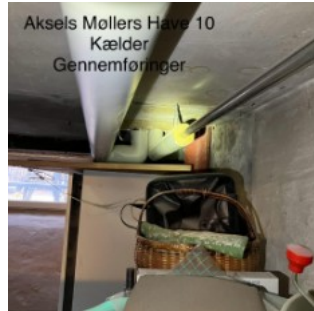
Aksels Møllers Have 10 - Gennemføringer i dæk ikke lukket
