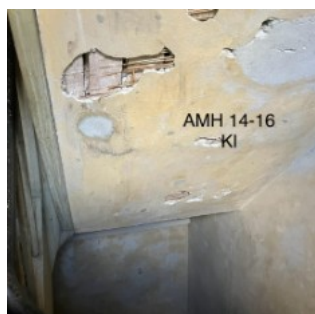
Pudsloft skal lukkes tæt uden huller
