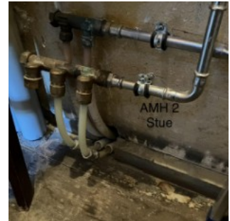
Aksels Møllers Have 2, stue - Nye installationer gennem væg
