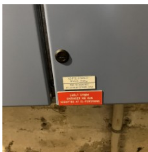
Tavle med 225A, skal i selvstændig brandcelle.
