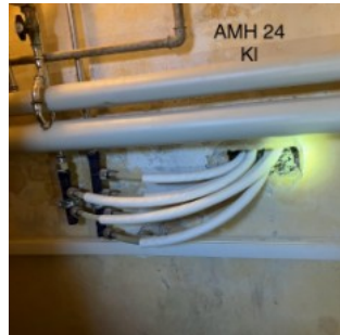
Aksels Møllers Have 24, kl. - rør og hul gennem væg
