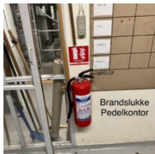
Håndildslukker ophængt og skiltet - OK
