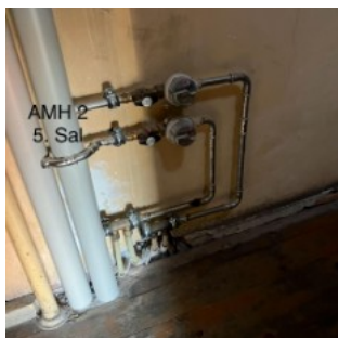
Aksels Møllers Have 2, 5. sal - Nye installationer gennem væg
