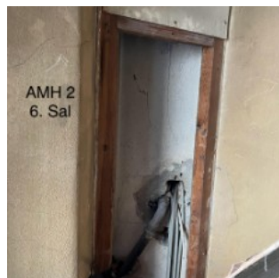
Aksels Møllers Have 2, 6. sal - ledning gennem væg
