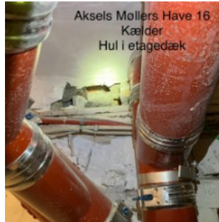
Aksels Møllers Have 16 - Gennemføringer i dæk ikke lukket
