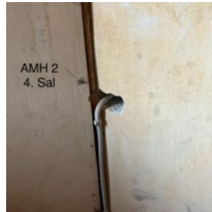
Aksels Møllers Have 2, 4. sal - ledning gennem væg
