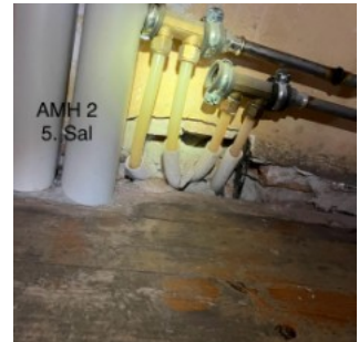
Aksels Møllers Have 2, 5. sal - Nye installationer gennem væg
