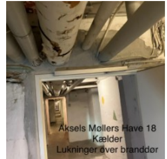
Aksels Møllers Have 18 - Lukning over dør ikke lukket
