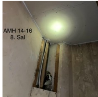
AMH 14-16 8. Sal Aksels Møllers Have 14-16, 8. sal. - Rør ført gennem nyt pladeloft
