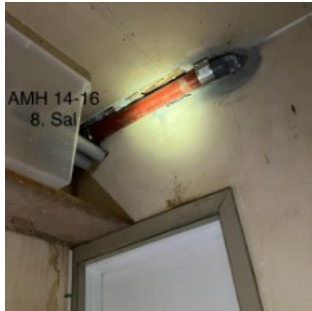
AMH 14-16 8. Sal Aksels Møllers Have 14-16, 8. sal. - Puds mangler, rør ført gennem væg
