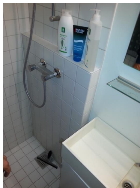
Et eksempel på nye skjulte rør. Denne løsning kan kun vælges de steder, hvor den oprindelige koksvæg er for tynd til at føre de nye rør i.
