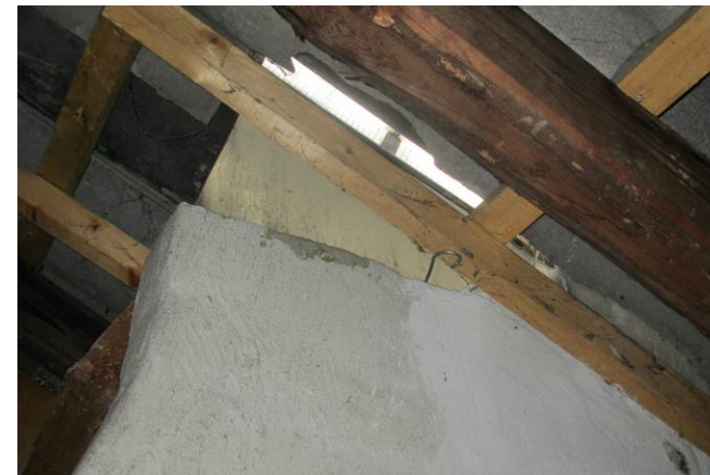
Ventilationskanaler ses ikke at være ført helt til hætter.
