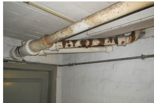
Eksempel på installation i kælder med mange tæringer.
