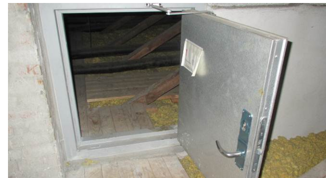
Brandsikringen ved sektioneringer er sikret med BD60 lem med dørpumpe og ved udstøbning mellem spær og BS60 indervæg.
