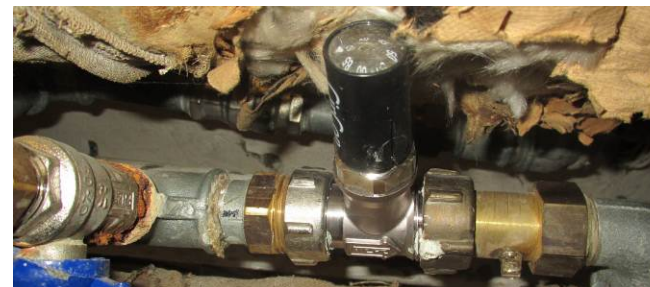
CirCon ventiler ses at være stillet meget højt – 65C hvilket gør dem "overflødige" idet det altid er åbne.
