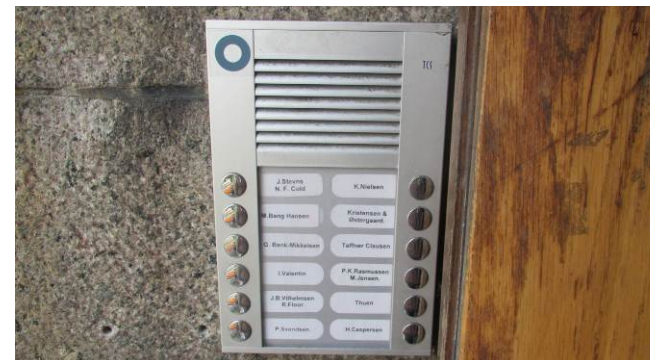
Dørtelefonanlæg er nyere TCS-anlæg med alm. telefoner (uden video).
