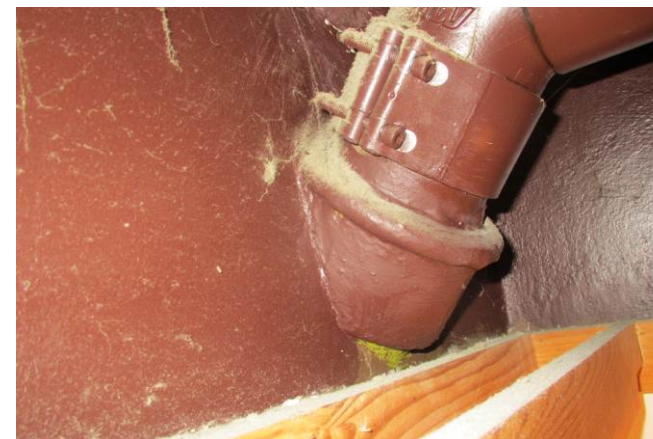
Faldstammeinstallationen fra badeværelset er ført i skjult væg/indmuret.
