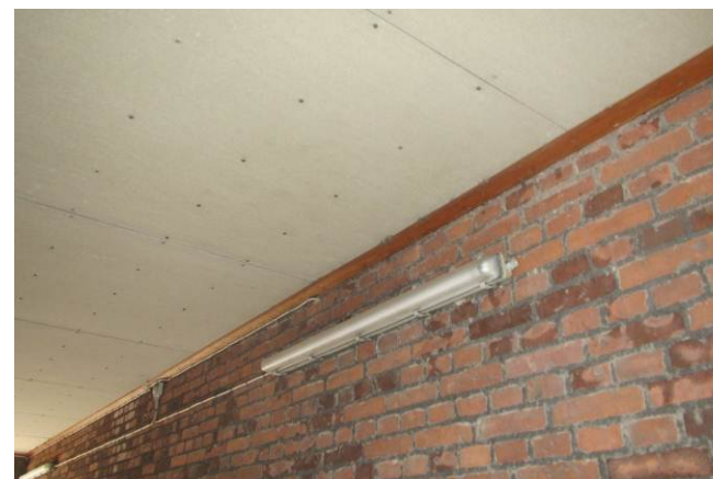
Der er 2 store lysarmaturer i porten og loftet ses at være efterisoleret.
