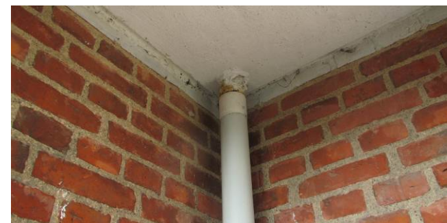
Nedløb er ikke udskiftet i gennemføringer på betonaltaner, hvilket kan medføre skader på sigt til altan/bygning.
