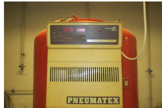
Trykekspressionsbeholder med pumpe.
