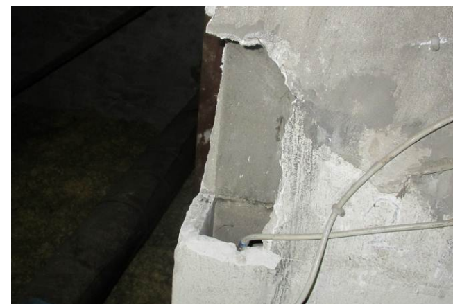
Kanaler er ødelagt enkelte steder og der er ført antennekabler.
