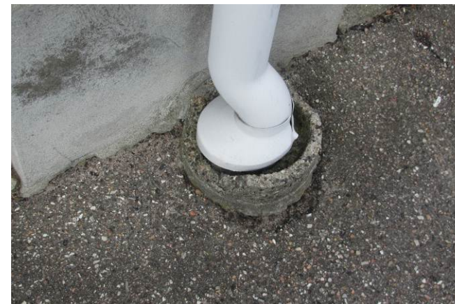
Kloaken i beton ses med enkelte skader. Tilslutningen fra nedløb er heller ikke korrekt ført – måske pga. hærværk / skade.
