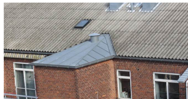
Taget set tættere på, bemærk trappetårne er beklædt med zink.
