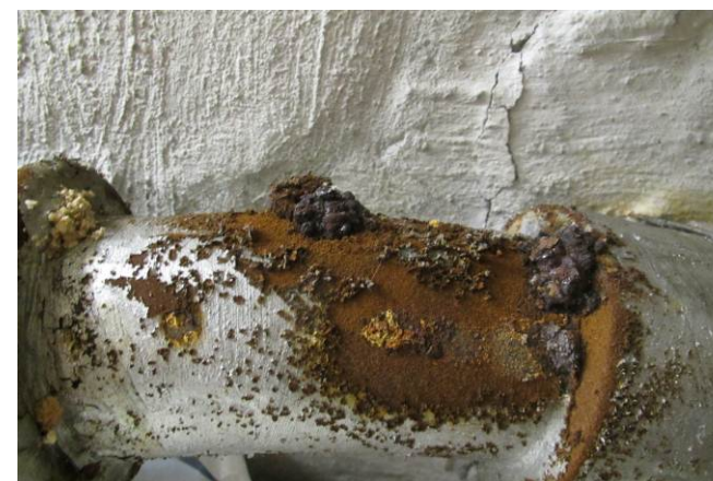
På faldstammeinstallationen ses tydelige tæringsspor som har udviklet sig over mange år.
