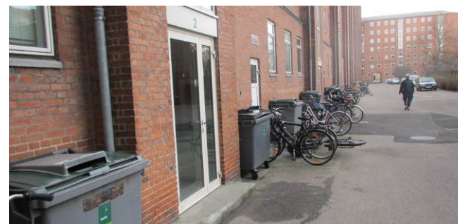
Dør til hovedtrappe mod gården og bag container ses bitrappedør
