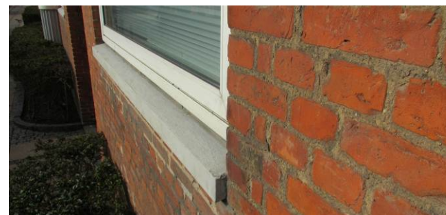
Sålænke ved vinduer udført i beton og afsluttet med betonfilts.
