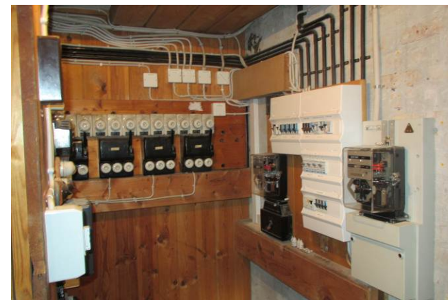
I kælder er el-tavler og sikringstavler for fællesstrøm.
