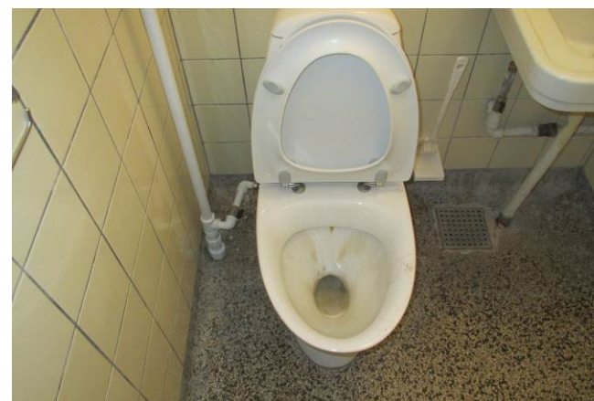
I badeværelset er der separat forsyning til toiletter. Det vil typisk ikke blive udført i en ny installation.
