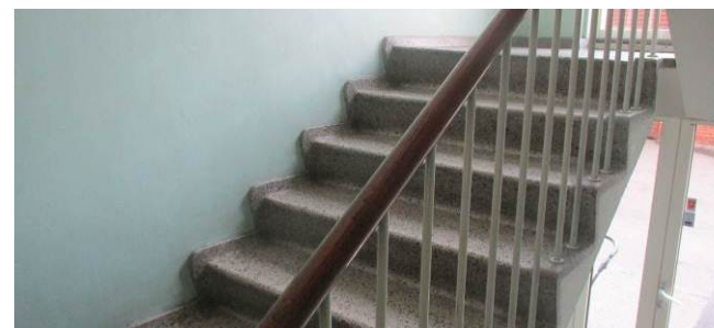
Hovedtrapperum i Aksel Møllers Have 4 (betontrappe).
