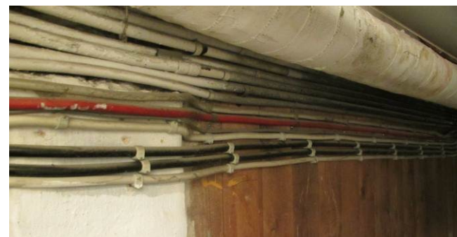
Både el, telefon, antenne (yousee) og elkabler er ført i kælder.
