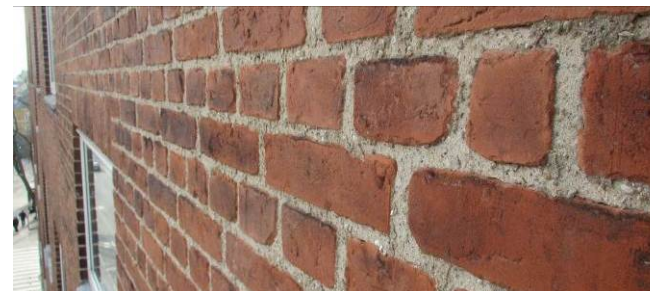
Fuger fremstår med nedbrudt overflade slutfuge, men ellers rimeligt intakte fuger. Fugerne kan i enkeltområder være mere medtaget som følge af graffiti eller hård vejrligsbelastning.
