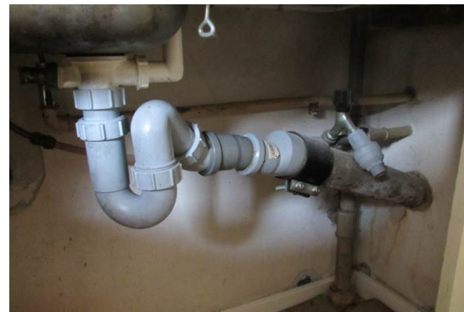
Installationen under køkkenskabet.
