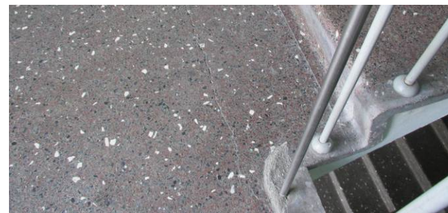
Revne i terrazzo ved støbeskel mellem reposer og løb.
