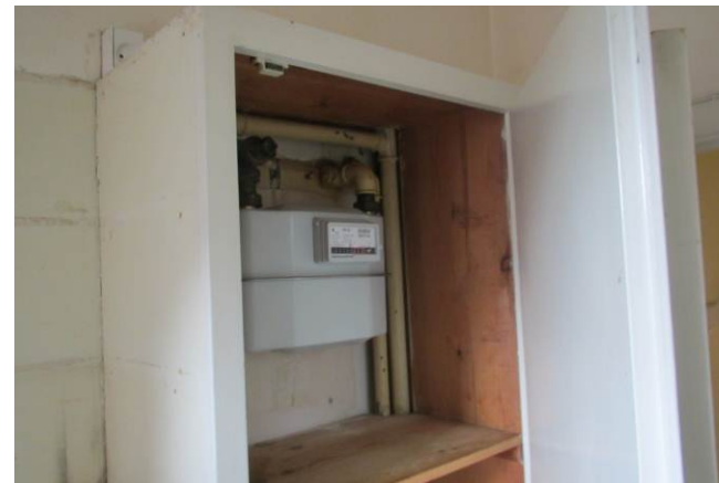
Stigeledninger i køkken og målerinstallation i køkkenskab.
