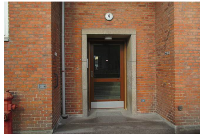
Indgangsdøre er nyere Schüco døre med el-slutblik tilsluttet dørtelefonen.
