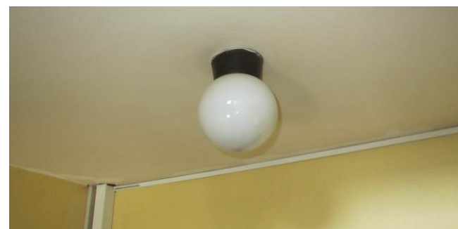
Belysning i bitrapperum består af lyskilder i fatning mens der er egentligt armatur på hovedtrappen. Begge dele er styret af trappelysrelæ (tidsrelæ).
