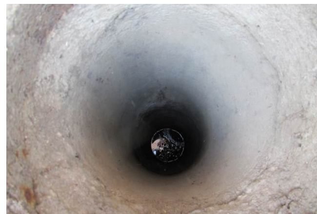
Betonbrønd som er rimelig intakt og uden synlige skader.
