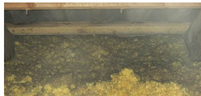
Udluftning ved tagfod ses ikke at være opfyldt. Isolering burde have været fastholdt af fast plade for at sikre ventilation af tag. Forholdet kan medføre råd/skimmelskader.
