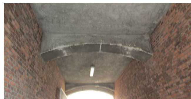
Hovedporten ved Aksel Møllers Have 26 fremstår blankmuret og uden supplerende isolering ved loft og vægge.
