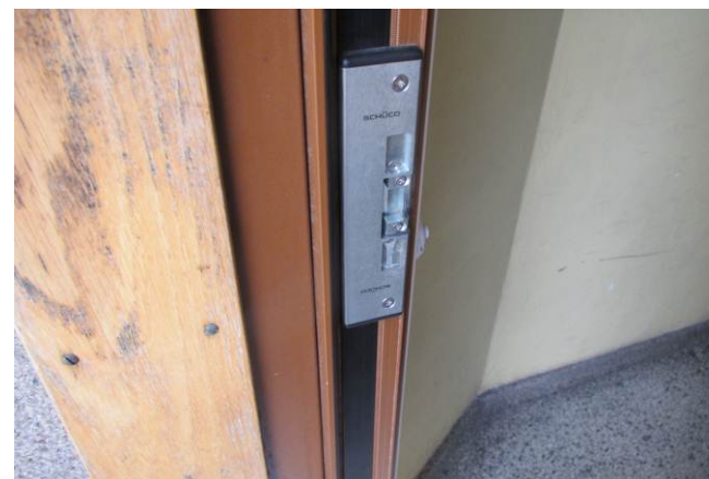
Indgangsdøre er nyere Schüco døre med el-slutblik tilsluttet dørtelefonen.
