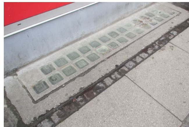
Lyskasser mod gadeside, udluftning ses at være støbt til.
