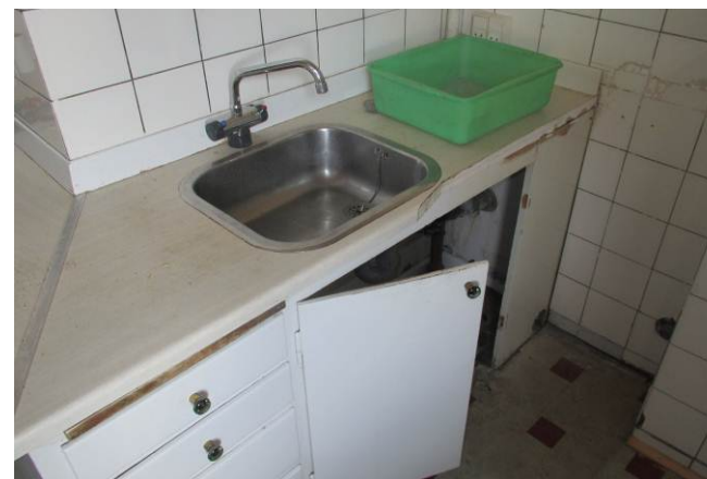
I køkkenet er der forsyning af koldt og varmt vand som i tilfælde som her også deles med badeværelset og nabo.
