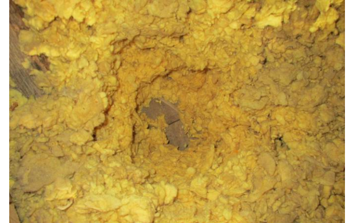
Granulatisolering på loft. Ved "frigravning" kunne tykkelse på ca. 300 mm måles.
