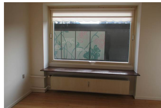
Radiatoranlæg er 1-strengt overfordelt og med indmurede stigestregne. Varmemålere på radiatorerne er af fordampningstypen.
