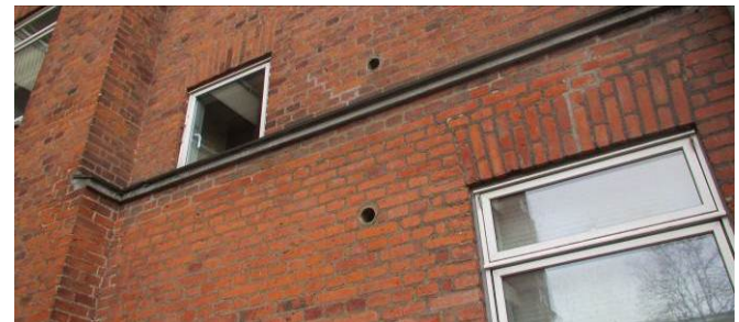
Facadespringet ved etageskel ses normalt kun inde i bygningerne, men her er det, sikkert som følge af bygningshøjden, tillige udført udvendigt.
