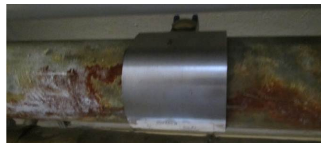
Der ses i kælderen mange "tætningsmuffer" hvilket tyder på en installation i dårlig stand og med kort levetid.
