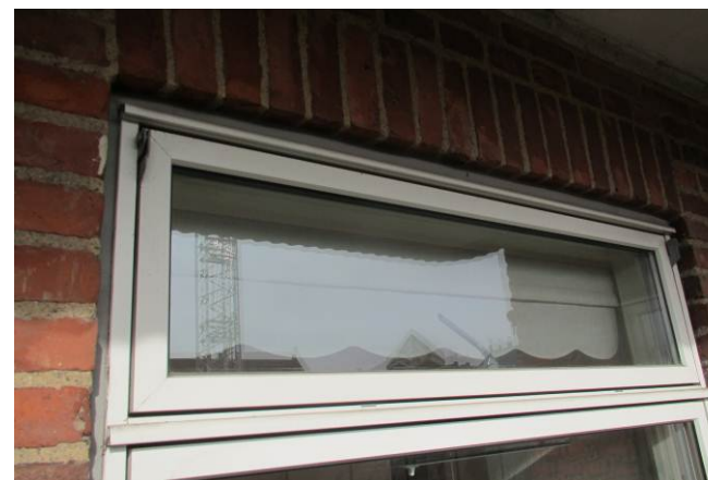
Udvendige fuger er udført i silikone og er vurderet udført ud fra 1-trins fugeprincippet.
