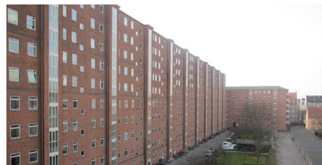
Facaden mod gårdsiden er domineret af facadeudspring ved trappetårne med de gennemgående vinduespartier samt stringent og ensartet muret facade og vinduesplacering. Udspring ved etagespring ses afdækket med naturskifer.
