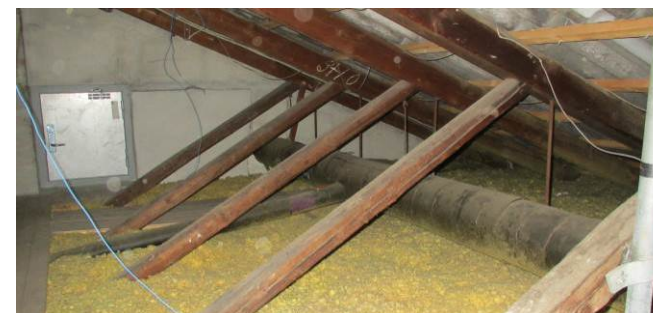
Foto fra loftrummet. Der ses at være isoleret med granulat.
