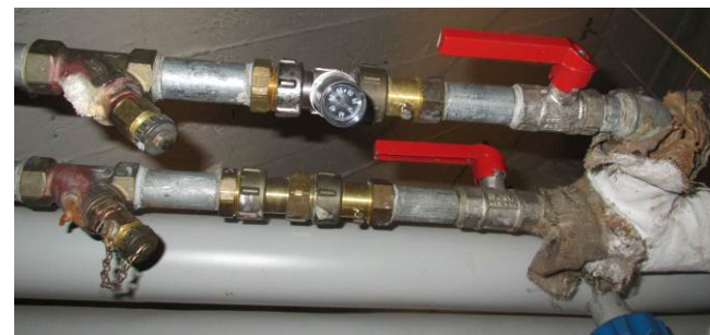
Isoleringen er ikke reetableret de steder hvor nye ventiler er indskåret.
