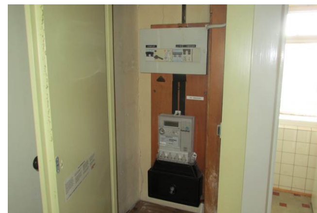
Der er i alle besigtigede boliger forsynet med 3 fase (400V) og tavler er forsynet med HFI/HPFI fejlstrømsrelæ.
