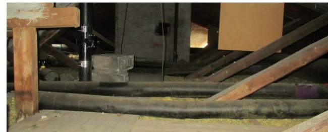
Fordeling af varmt brugsvand er traditionelt udført med en øvre fordeling. Installationen er isoleret i nyere tid.
