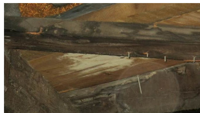
Ved skotrender mod trappetage ses træværk at have været opfugtet.
