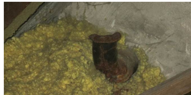
Faldstammeudluftning ses at være knækket af og bidrager med fugtig rumluft (med mindre den er afproppet længere nede på installationen). Der var dog en hætte umiddelbart over.
