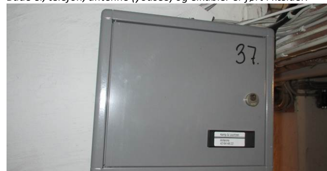
Fordelerbokse/pakkebokse for Yousee er monteret i kælder.
