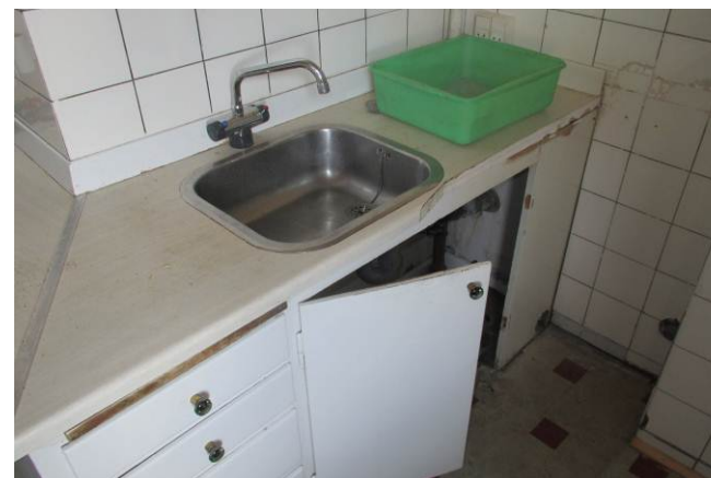
Køkken som er oprindeligt forrammekøkken, dog med udskiftet bordplade, armatur, vask m.v.
