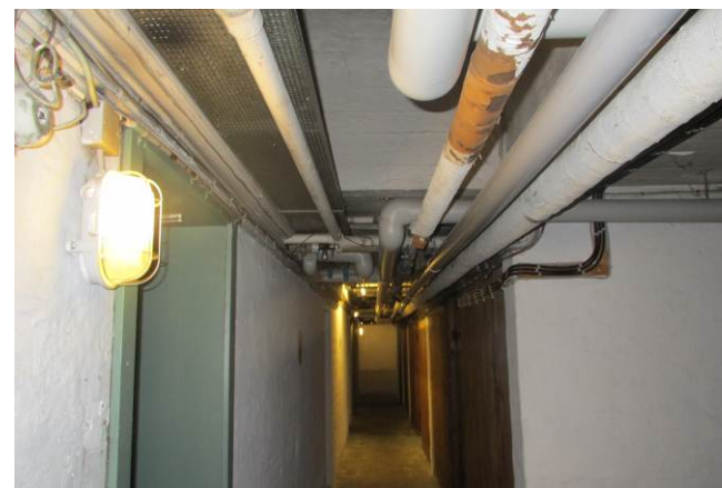
Gasledning er ført i kælder og fordeler herfra til lejligheder.
