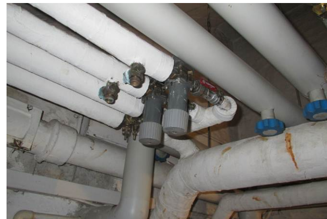
Returventiler på stigeledningerne til regulering af varmen.
