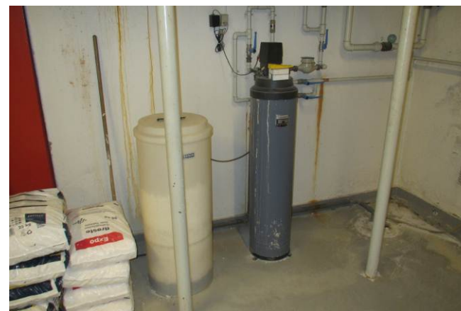
Vandbehandling til radiatoranlæg.
