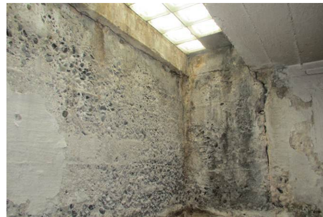
Lyskasse set indefra. Overfladebehandling / beton ses nedbrudt, og der blev konstateret fugtigt beton ved fugtmåling.
